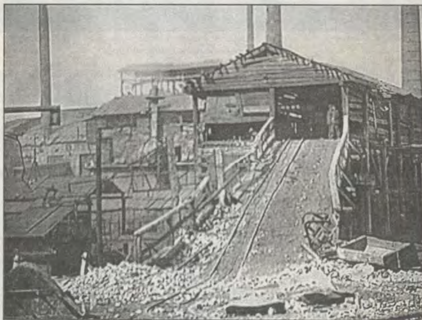
Въезд в доменную печь.
